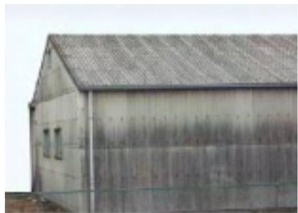
石綿含有スレート波板（屋根・外壁）
